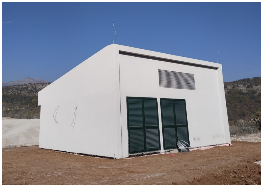
Slika 5.2: Građevinski objekat TS 20/0,4 kV
