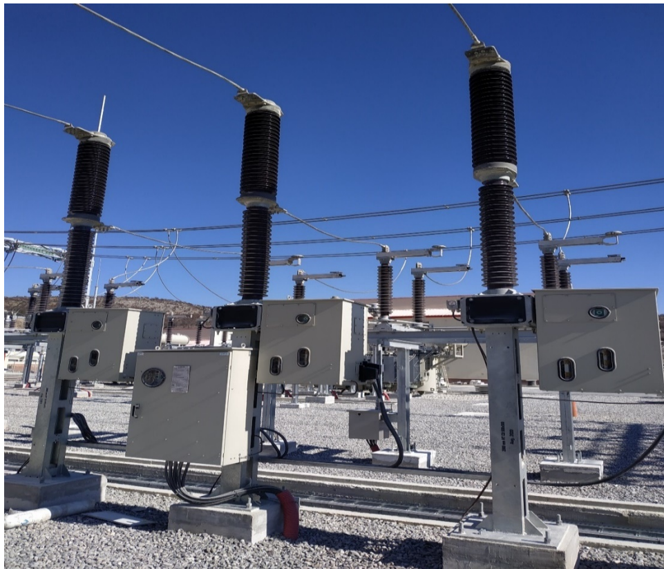
Slika 4.9: Visokonaponski SF6 (3API – FG 145 kV) prekidač
